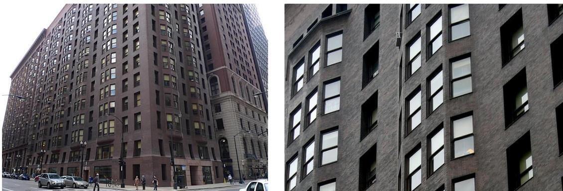
Figura 2.2 – Edifício Monadnock em Chicago com destaque para paredes superdimensionadas (Cerâmica Vale da Gândara<sup>4</sup> (2018))
