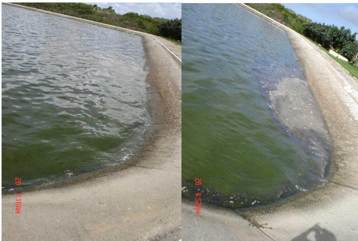
**Figura 5.4** Vista da entrada da lagoa facultativa com pouca formação de lodo flotante devido à grande influência dos ventos que desestabilizam os flocos.
