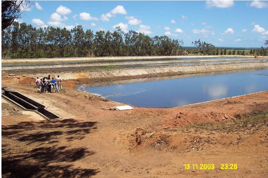
**Figura 3.3** Vista do sistema de lagoas de estabilização de Ceará-Mirim/RN (Foto retirada em novembro de 2003, logo após a limpeza da primeira lagoa anaeróbia. Destaque para a formação de espuma na segunda lagoa anaeróbia).
