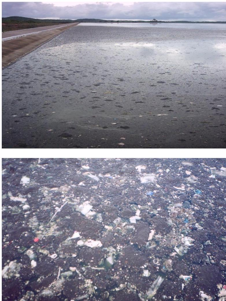
**Figura 5.1 Lodo flotante característico do tratamento de esgoto em lagoa facultativa primária da ETE Ponta Negra.**
