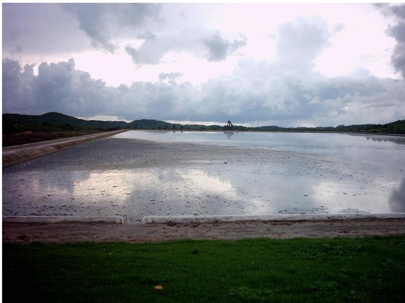
**Figura 4.6** Vistas da camada de lodo flotante acumulada na lagoa facultativa primária da ETE Ponta Negra próximo ao talude de entrada.
