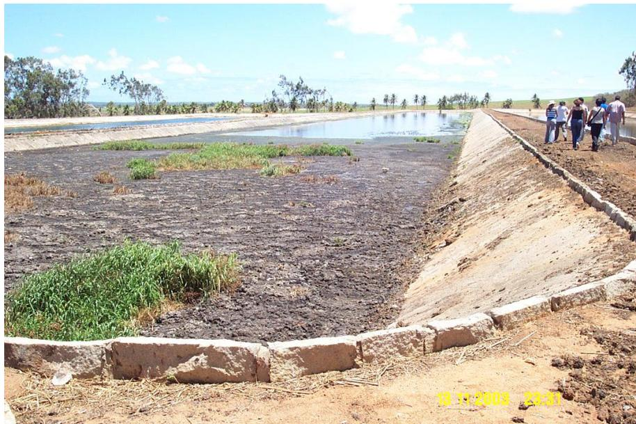
**Figura 3.2 Vista do sistema de lagoas de estabilização de Ceará-Mirim/RN (Foto retirada em novembro de 2003. Destaque para a grande quantidade de lodo flotante na segunda lagoa anaeróbia e começo do desenvolvimento de vegetação).**
