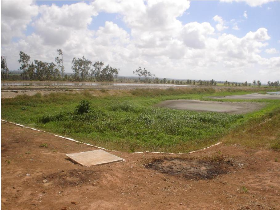
**Figura 3.5** Vista do sistema de lagoas de estabilização de Ceará-Mirim/RN (Foto retirada em novembro de 2005. Destaque para a grande quantidade de lodo flotante na primeira lagoa anaeróbia, inclusive com o estabelecimento de vegetação, dois anos após sua limpeza).
