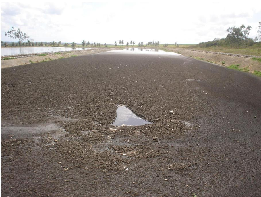
**Figura 3.4** Vista do sistema de lagoas de estabilização de Ceará-Mirim/RN (Foto retirada em novembro de 2005. Destaque para a grande quantidade de lodo flotante na segunda lagoa anaeróbia ainda sem o desenvolvimento de vegetação).
