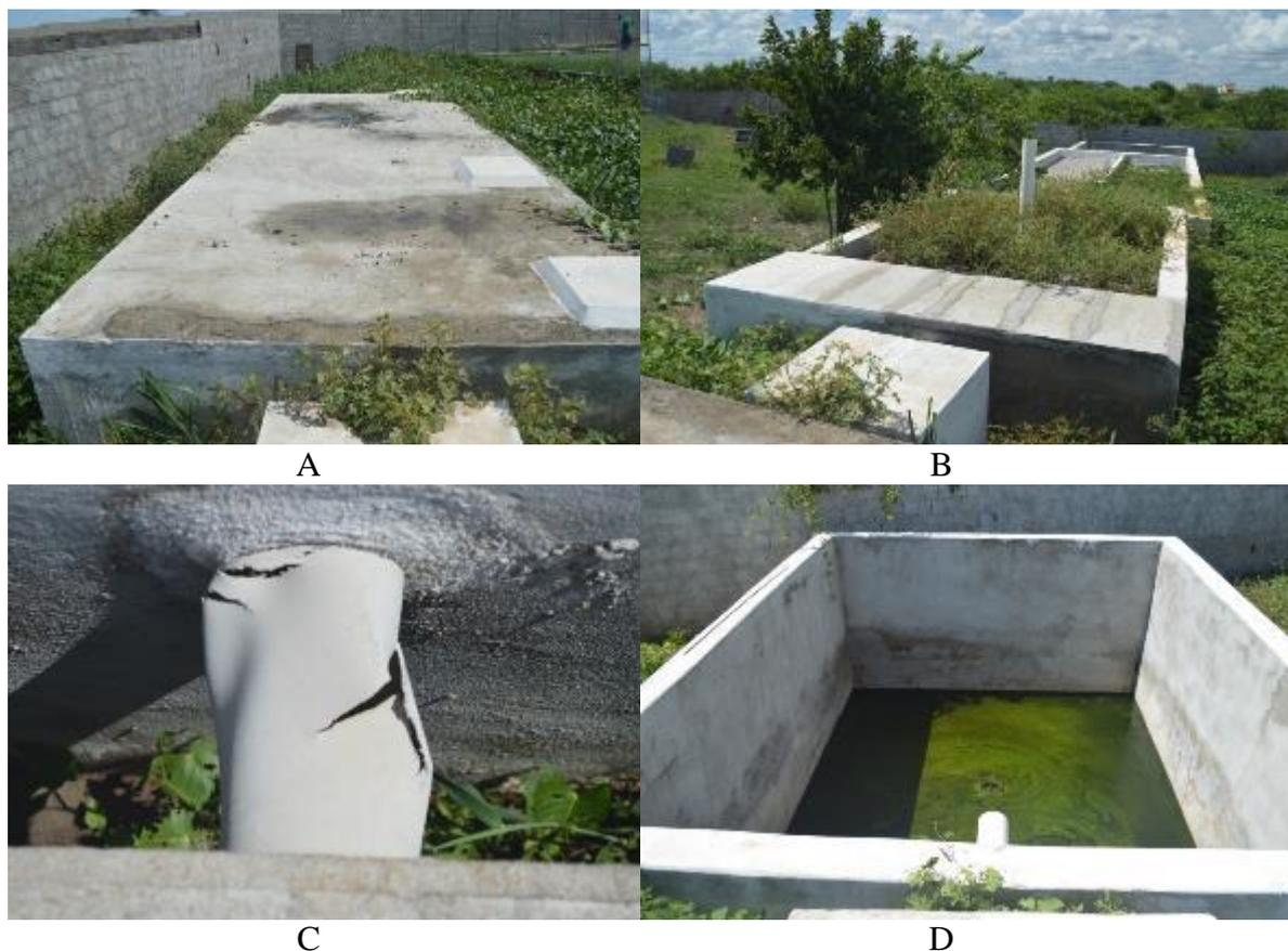
Figura 5 - Vistas das unidades da ETE no Campus Pau dos Ferros – IFRN (A – tanque séptico; B – filtro anaeróbio e wetland com destaque para a presença de vegetação nas unidades; C – detalhe de tubulação quebrada entre o wetland e reservatório de efluente tratado; D – reservatório de efluente tratado).
