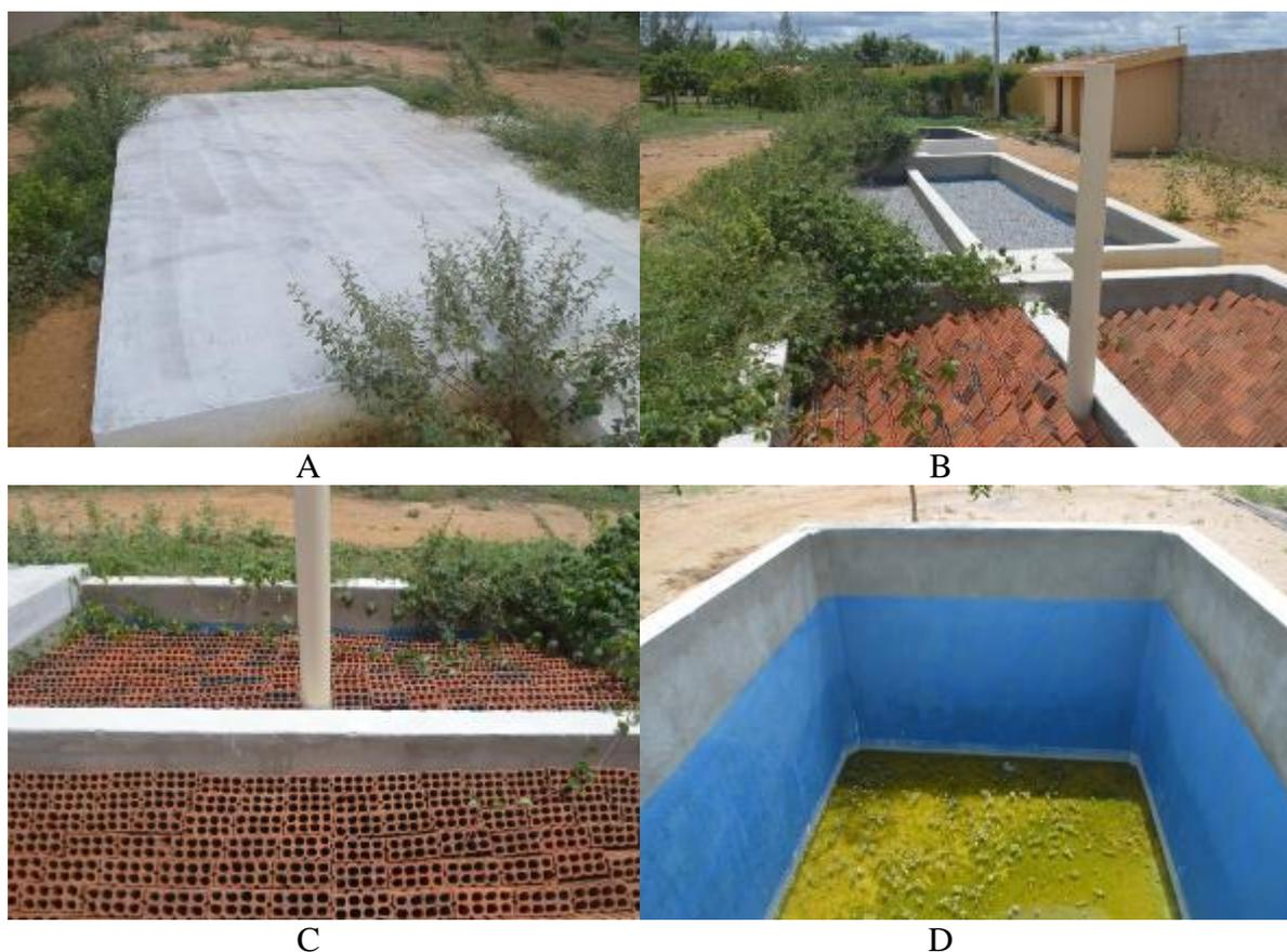
Figura 4 - Vistas das unidades da ETE no Campus Apodi – IFRN (A – tanque séptico; B – filtro anaeróbio e wetland; C – filtro biológico, com detalhe do material de suporte; D – reservatório de efluente tratado).
