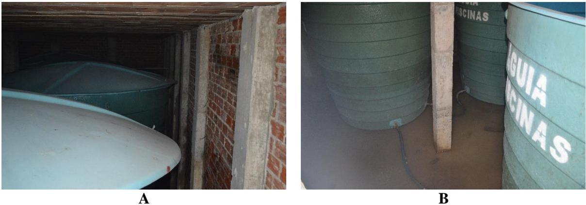
Figura 20 - Vista dos reservatórios de água de chuva no campus de Canguaretama (a – prédio principal; b – ginásio).
