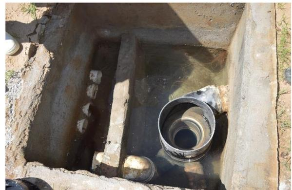
Figura 24 - Vista dos filtros instalados a montante dos reservatórios no campus de Currais Novos.
