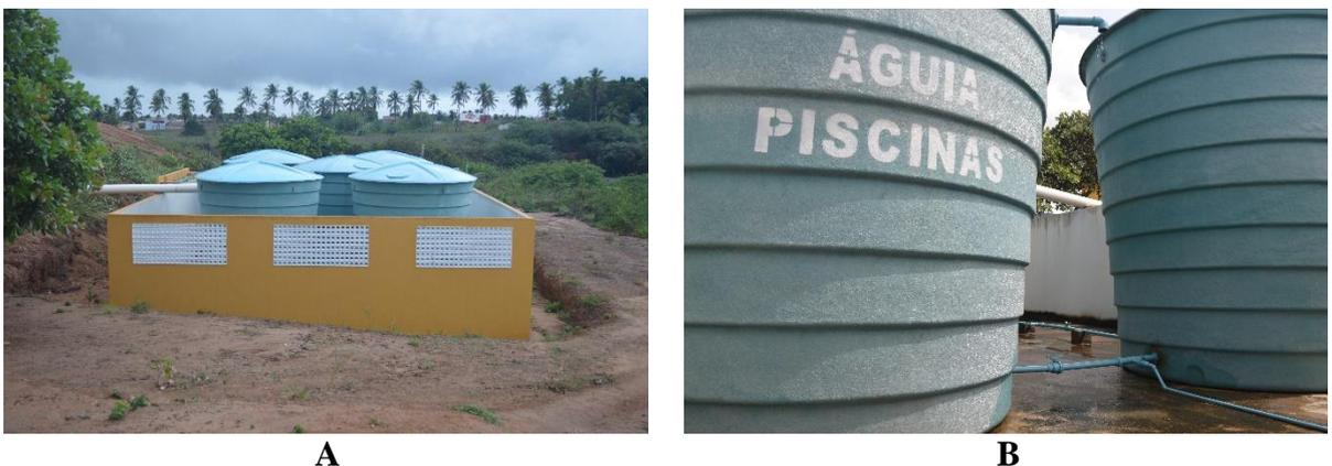
Figura 21 - Vista dos reservatórios de água de chuva no campus de Ceará-Mirim (a – vista geral; b – detalhe do extravasor e vasos comunicantes).
