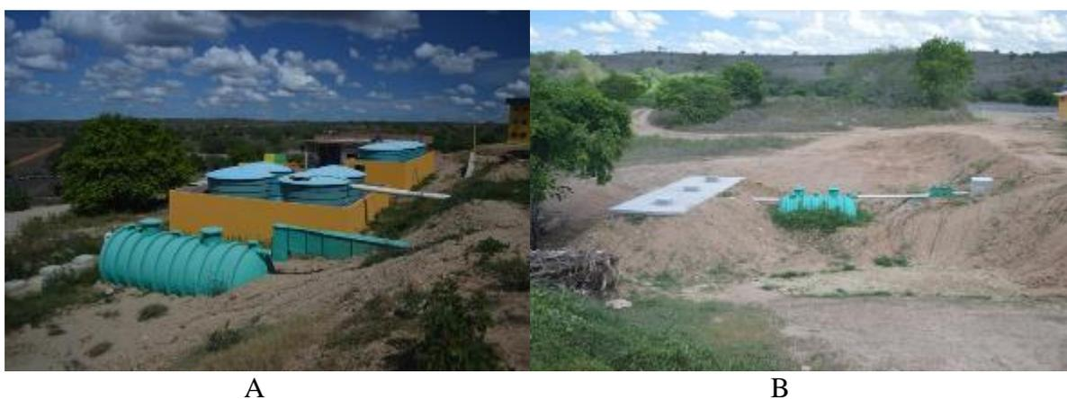
Figura 10 - Vistas das unidades da ETE no Campus São Paulo do Potengi – IFRN (A – ETE 1: unidade de tanque séptico-filtro anaeróbio; B – ETE 2: unidade de tanque séptico-filtro anaeróbio).
