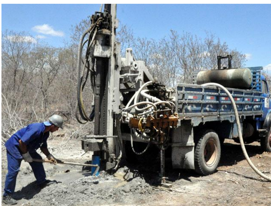
Figura 15. Perfuração de poço artesiano. Por AESA (2013)
