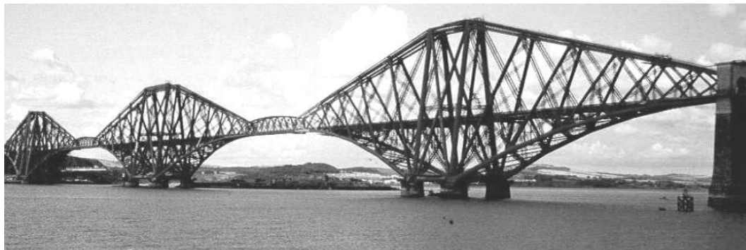
Figura 1.2 - Forth bridge, Escócia. Fonte: Argan (1999)
