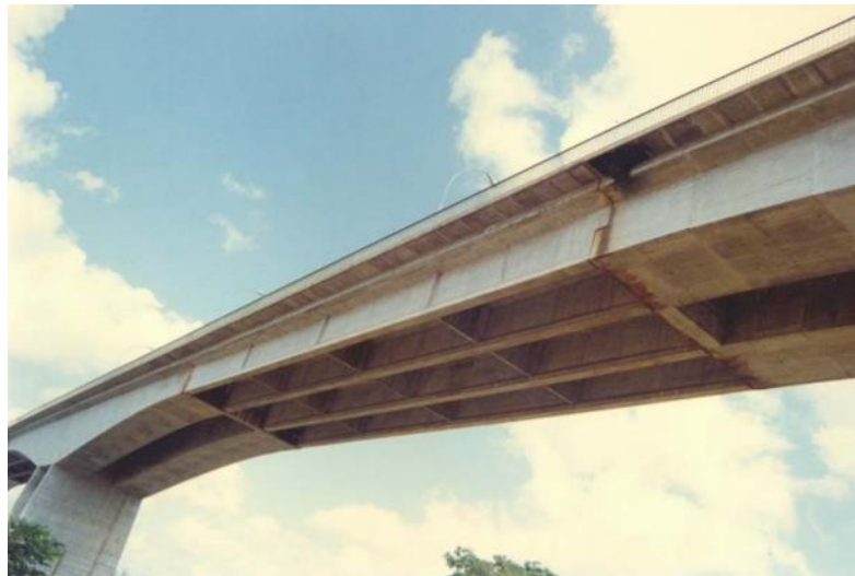
Figura 2.22 - Ponte rodoviária sobre o Rio Parnaíba, em Teresina/PI, Projeto de 1969, com vão de 120m e uso de longarinas protendidas pré-moldadas com 40m. Nesse caso foram usadas quatro transversinas intermediárias. Araújo (2005)
