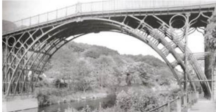
Figura 1.1 - Ponte Coalbrookdale, Inglaterra. Fonte: Lopes et al. (2006)
