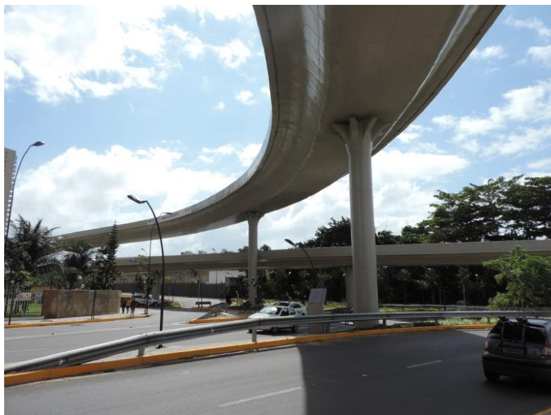
Figura 1.4 - Viaduto de Fortaleza. Fonte: Mota et al. (2016)
