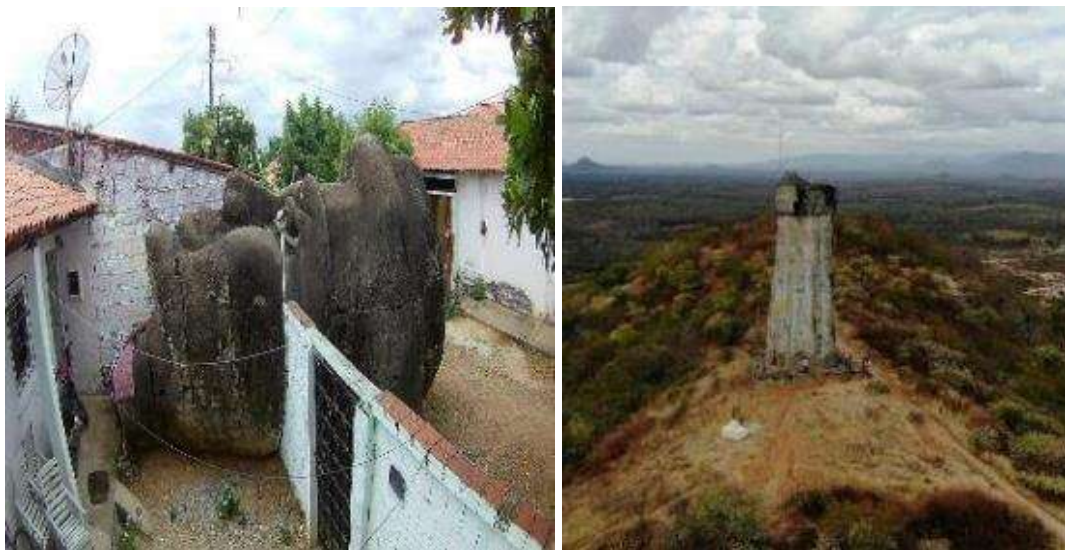
Figura 10 - Cabeça de Santo Antônio e ruínas do monumento no município de Caridade (CE)
