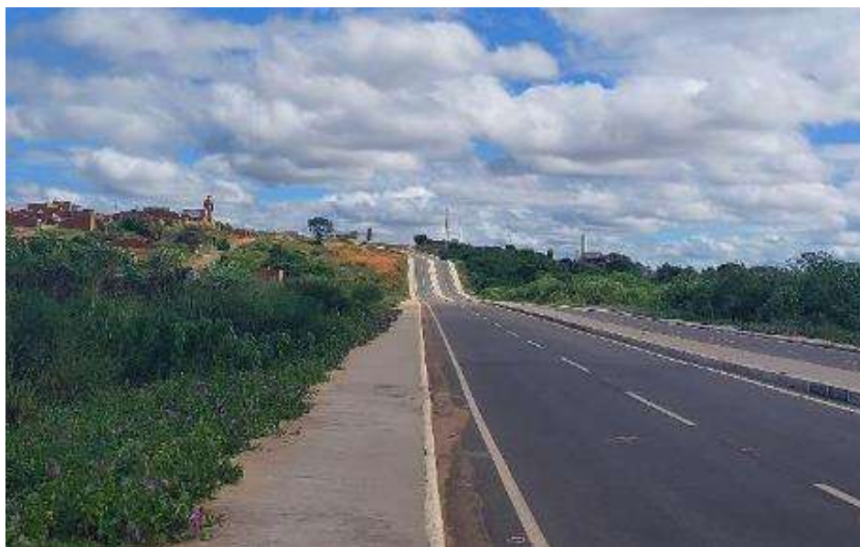
Figura 43 - Via de acesso ao Monumento de Santo Antônio em Barbalha (CE)
