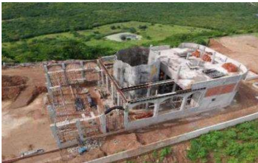
Figura 11 - Imagem da obra em andamento no complexo religioso em Caridade (CE)
