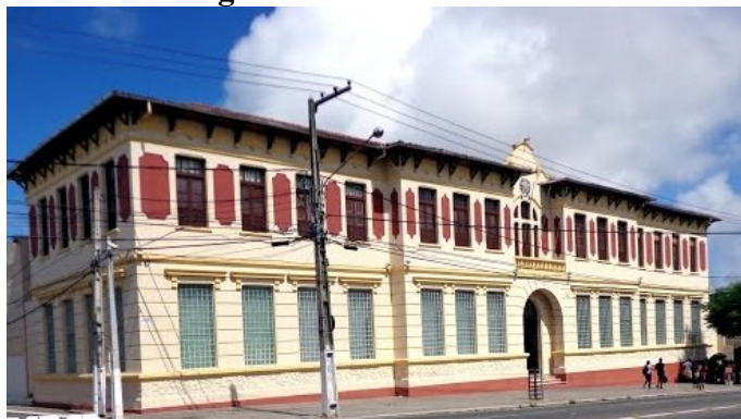
Figura 67: Prédio do IFRN
