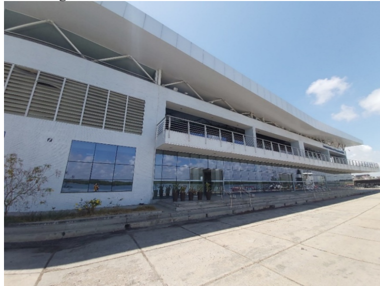
Figura 28: Estrutura externa do TMP de Natal
