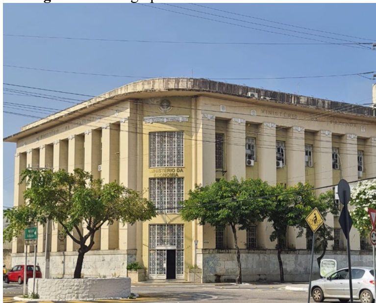
Figura 87: Antigo prédio do Ministério da Fazenda
