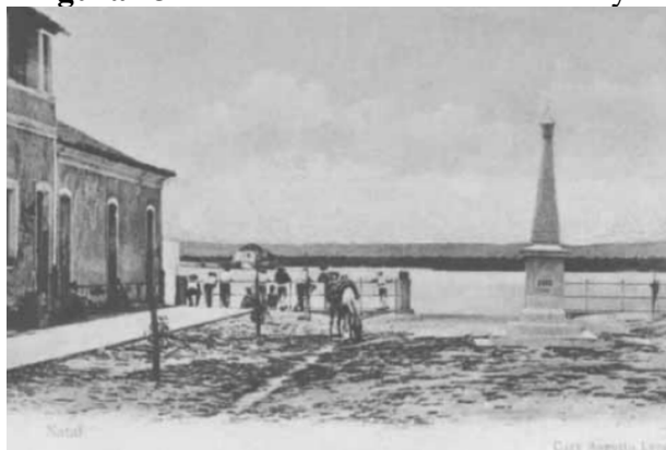
Figura 23: Cais da Avenida Tavares de Lyra
