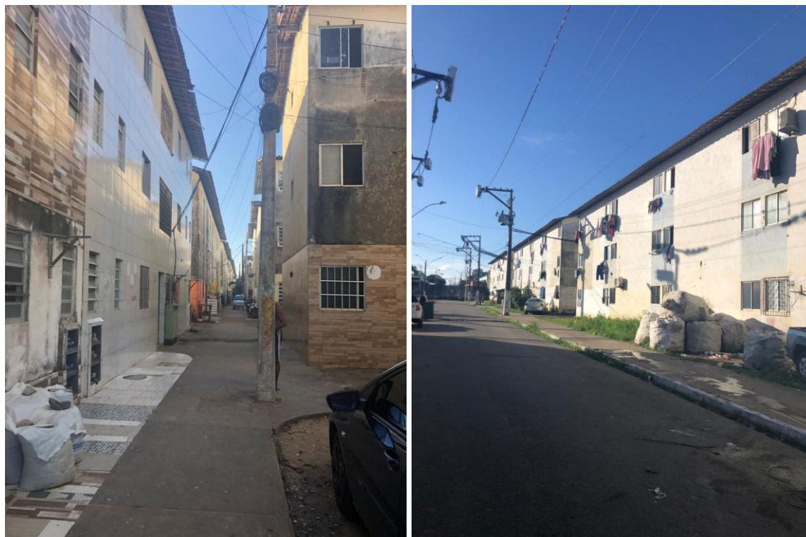
Figura 16 - Conjunto Habitacional ‘Vila dos Pescadores’, que passou a abrigar 450 famílias retiradas da Vila dos Pescadores do Jaraguá
