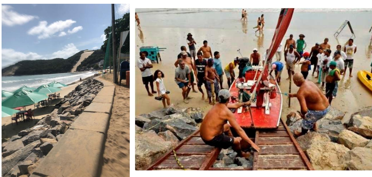
Figura 29 - Resultado da obra de enrocamento (à esquerda) e pedras colocadas na área que pescadores utilizam para atracar suas embarcações (à direita)
