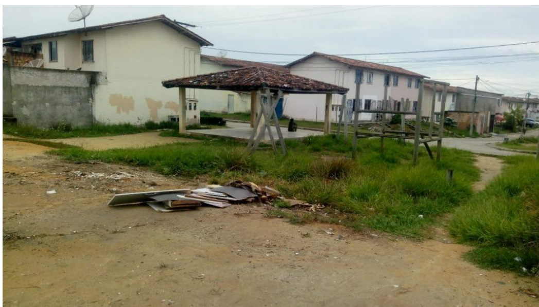
Figura 16 - Vista Parcial de rua no Bairro Vila Valdete (Complexo Baianão)
