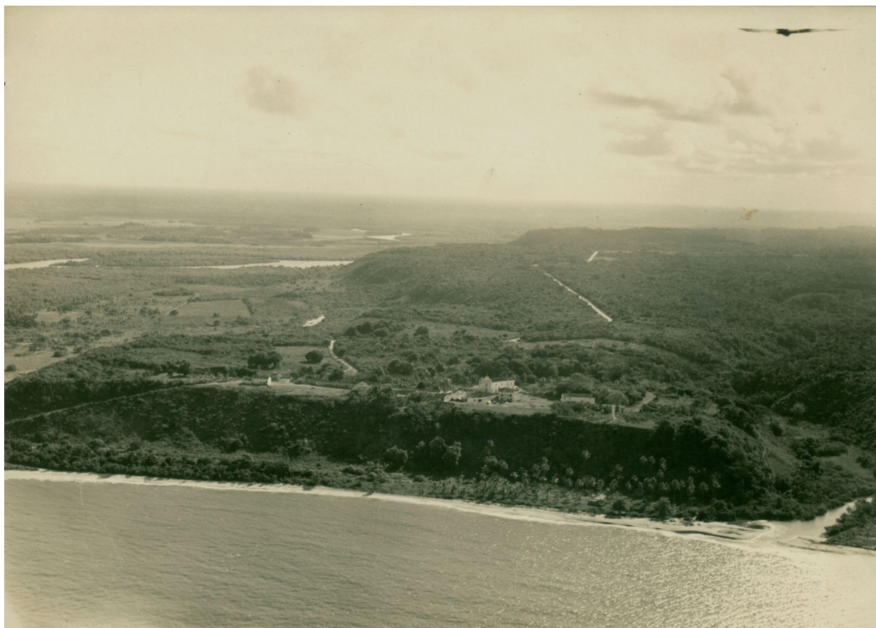
Figura 1 - Vista aérea da Cidade Alta de Porto Seguro (1957)
