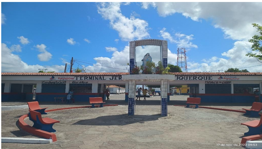
Figura 32: Terminal Hidroviário de Primeira Cruz
