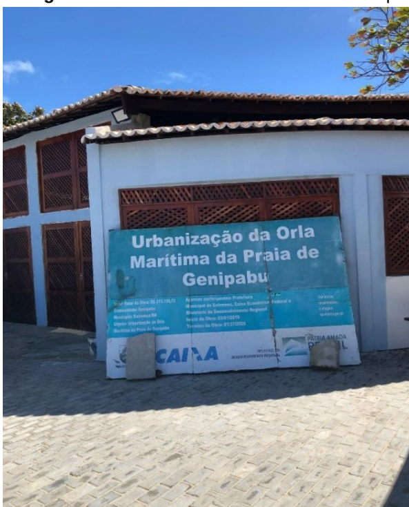
Imagem 15: Obra inacabada na Praia de Jenipabu
