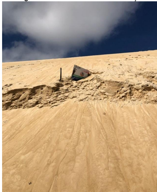
Imagem 16: Placa deteriorada fiscalização.
