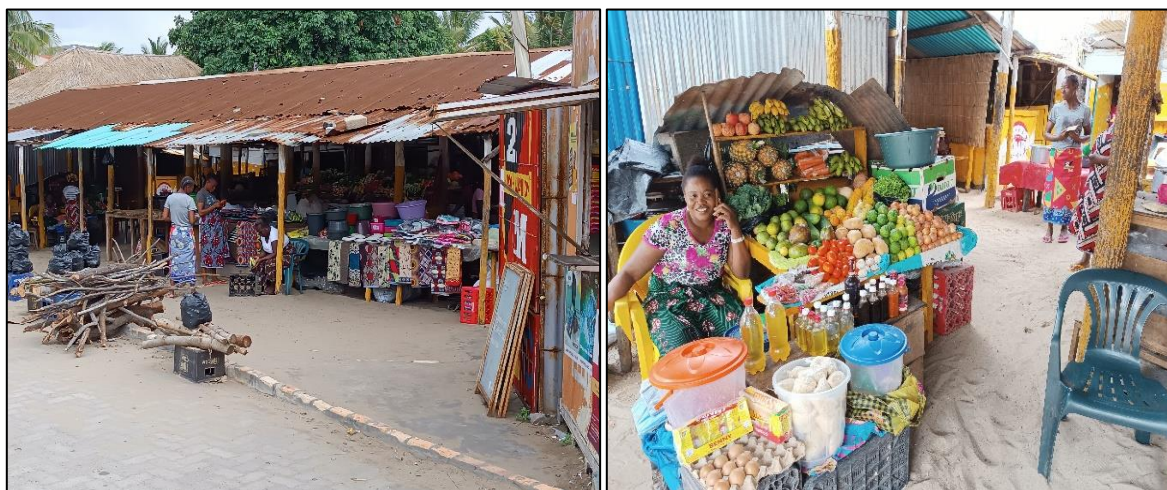
Figura 38 - Infraestrutura do mercado de vegetais do Tofo
