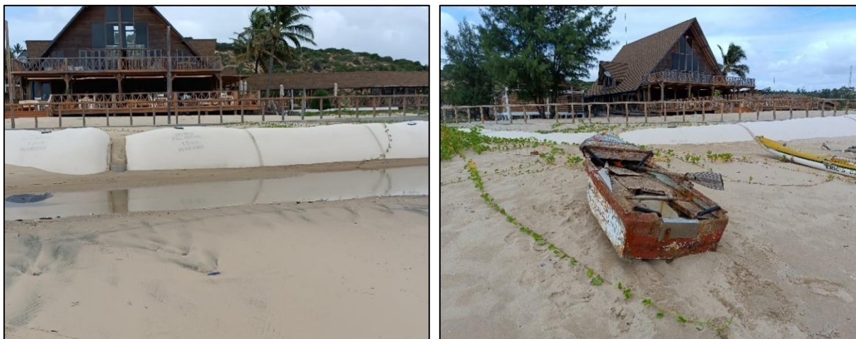
Figura 52 - Infraestrutura construída em local inapropriado na praia da Barra no MI
