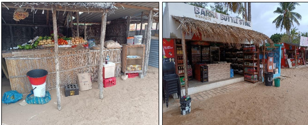
Figura 39 - Condições das infraestruturas do mercado da praia da Barra
