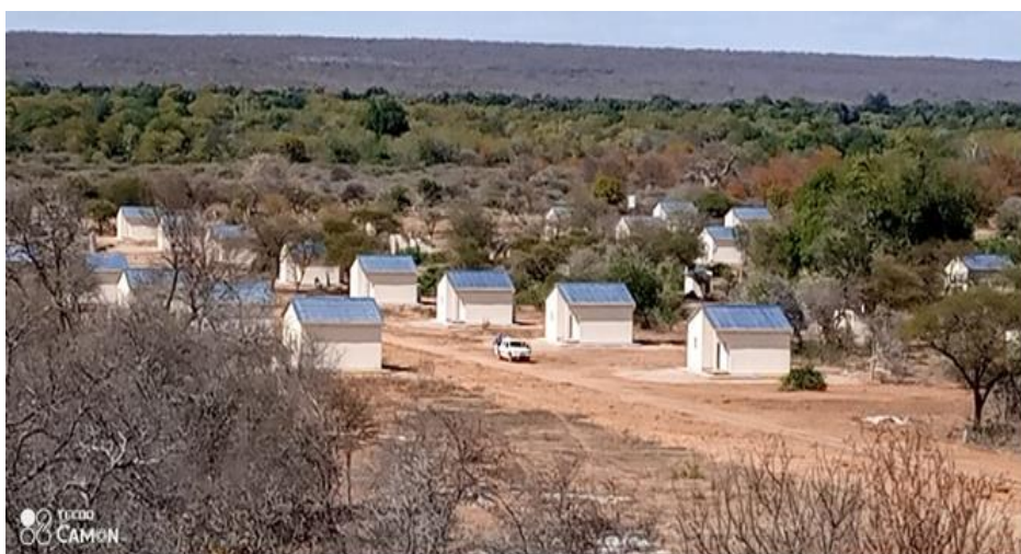
Figura 57: Casa de reassentamentos das comunidades Fonte: (PNL, 2021, p. 2)
