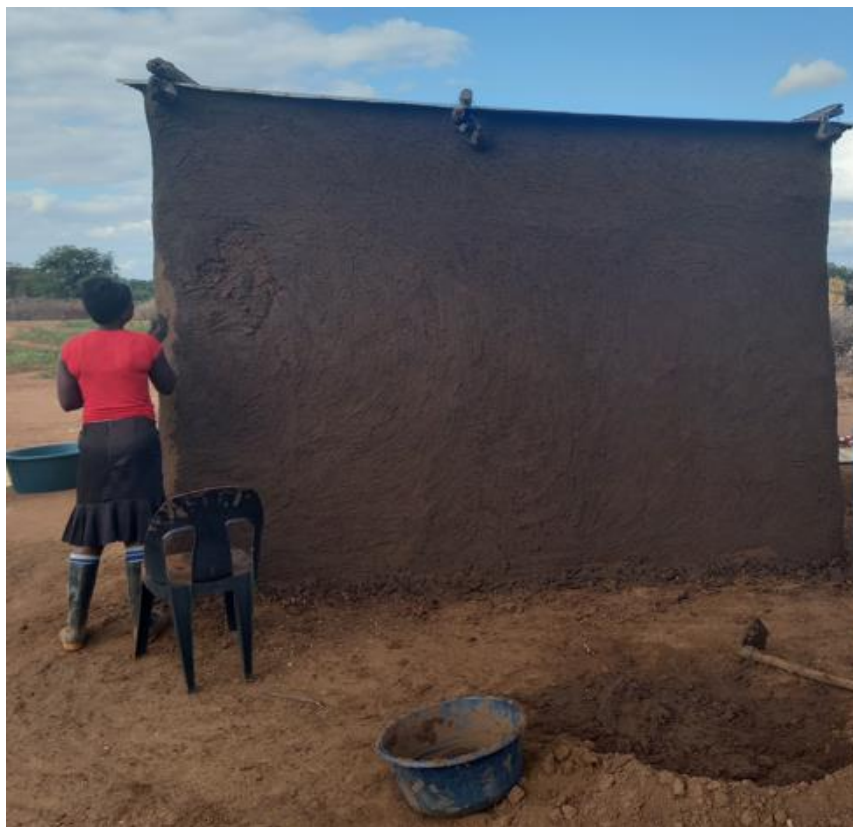
Figura 5: construção de habitação
