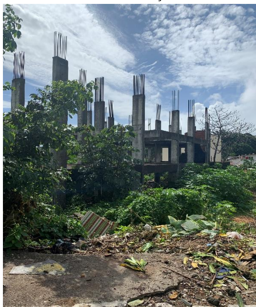
Figura 19. Vazios urbanos em impedimento de construção
