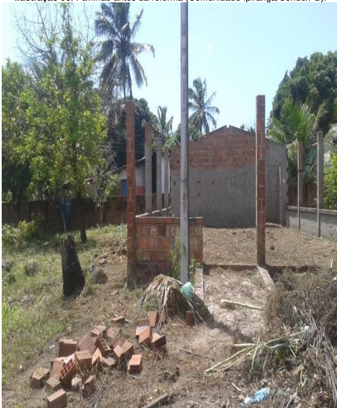
Ilustração 96. Pavilhão antes da reforma (Comunidade Ipiranga/Conde/PB).
