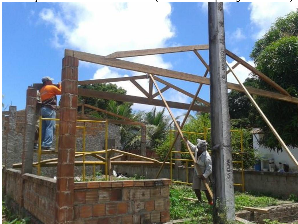
Ilustração 97. Pavilhão em reforma (Comunidade Ipiranga/Conde/PB).
