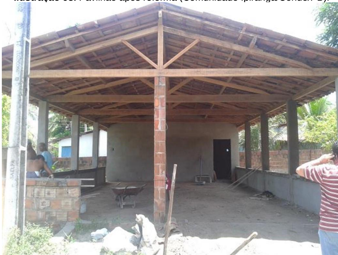
Ilustração 98. Pavilhão após reforma (Comunidade Ipiranga/Conde/PB).
