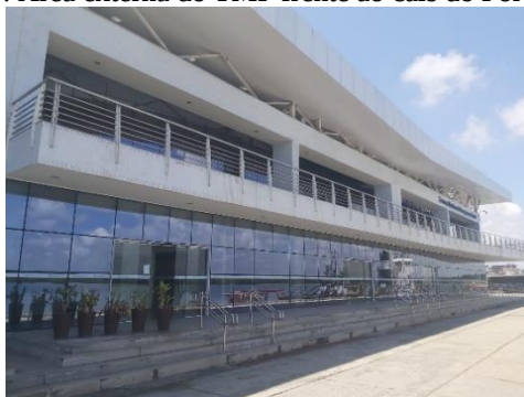
Figura 10: Área externa do TMP frente ao cais do Porto de Natal.
