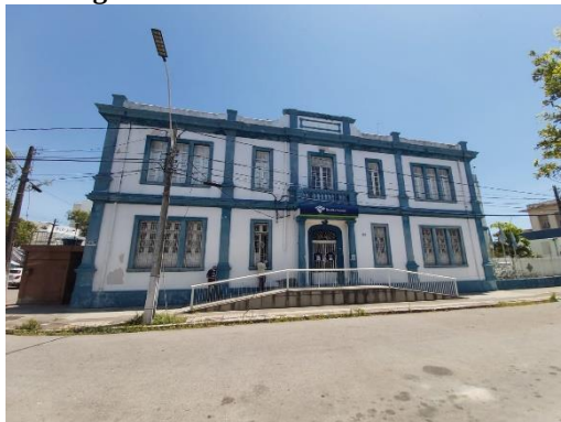
Figura 26: Prédio da Receita Federal
