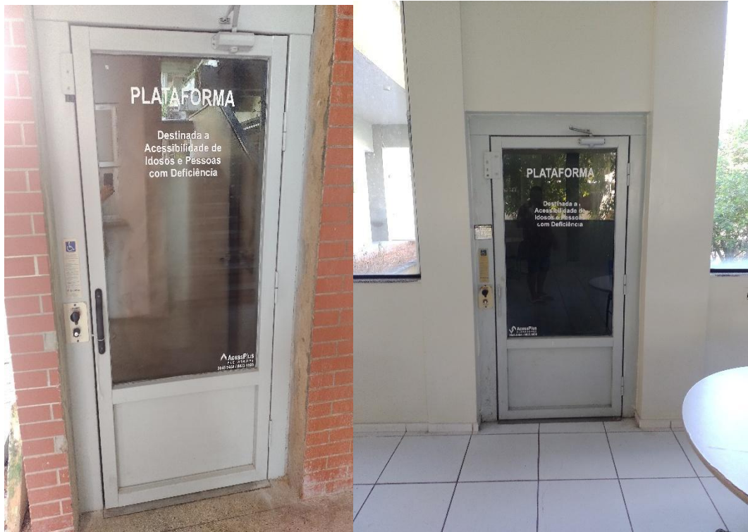
Figura 3 - Elevadores para permitir a acessibilidade no Centro de Biociências.
