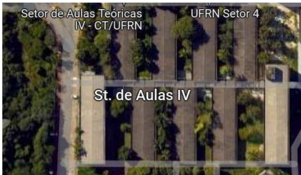
Figura 02 – Vista aérea do Setor de Aulas Teóricas IV
