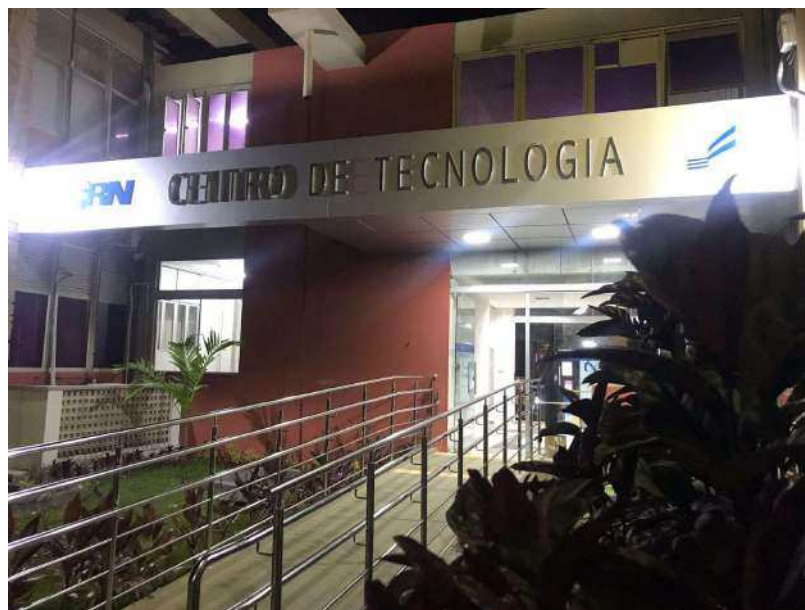
Figura 18 – Rampa de acesso ao Pavilhão Administrativo
