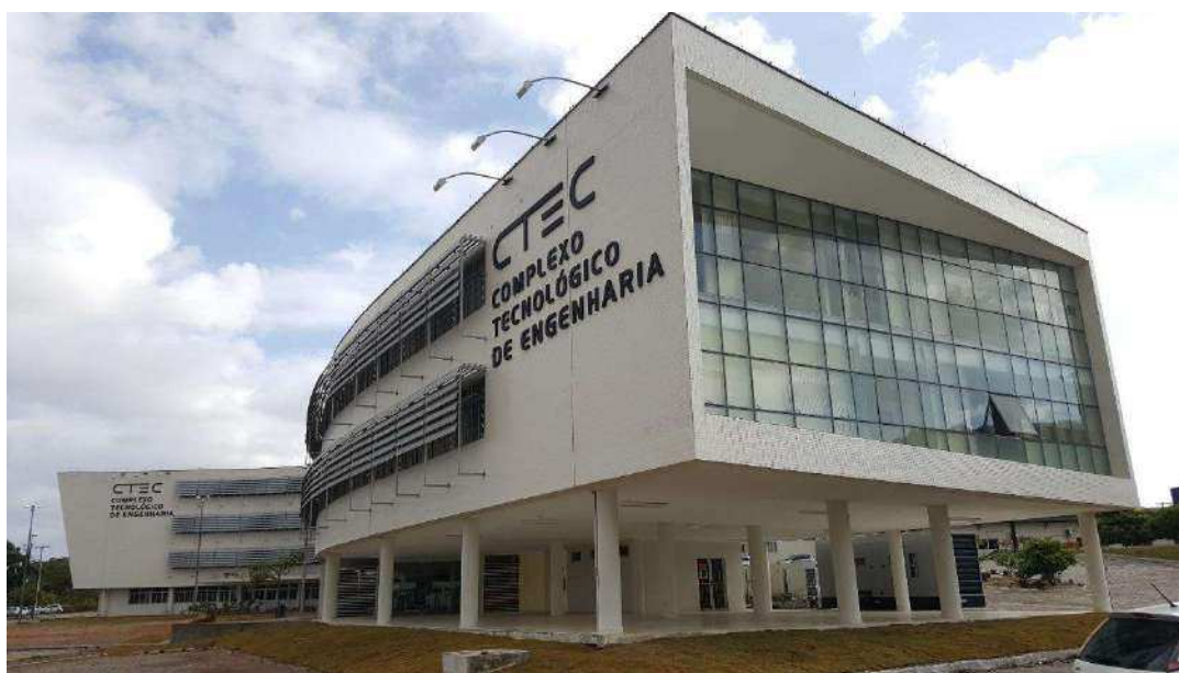
Figura 07 – Complexo Tecnológico de Engenharia – CTEC
