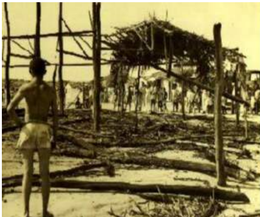
Figura – Restos do acampamento escolar das Rocas após incêndio
