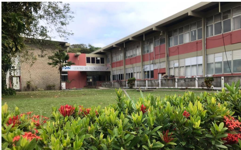
Figura 05 – Prédio Administrativo do Centro de Tecnologia
