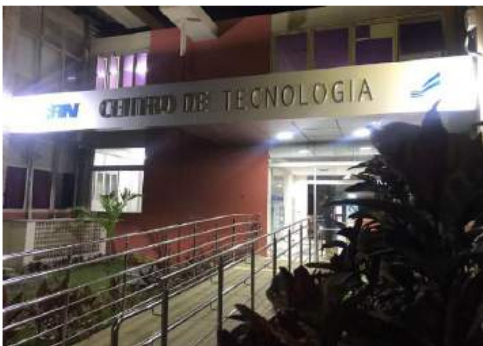
Figura 2 – [Descrição da imagem] Rampa de acesso ao Pavilhão Administrativo. [Fim da descrição]
