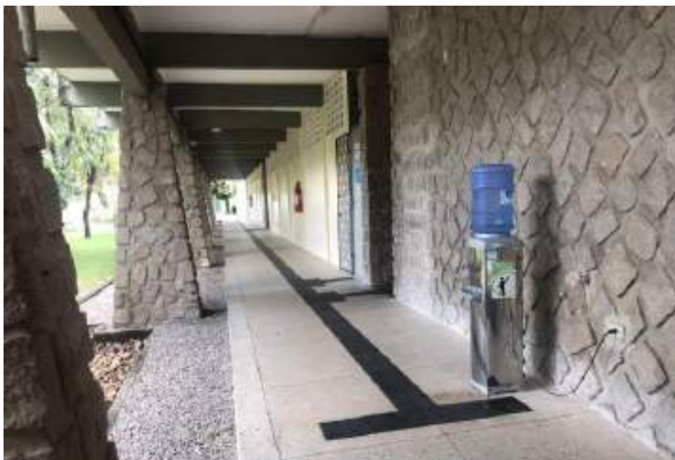
Figura 1 – [Descrição da imagem] Piso Tátil Direcional no Setor IV. [Fim da descrição]
