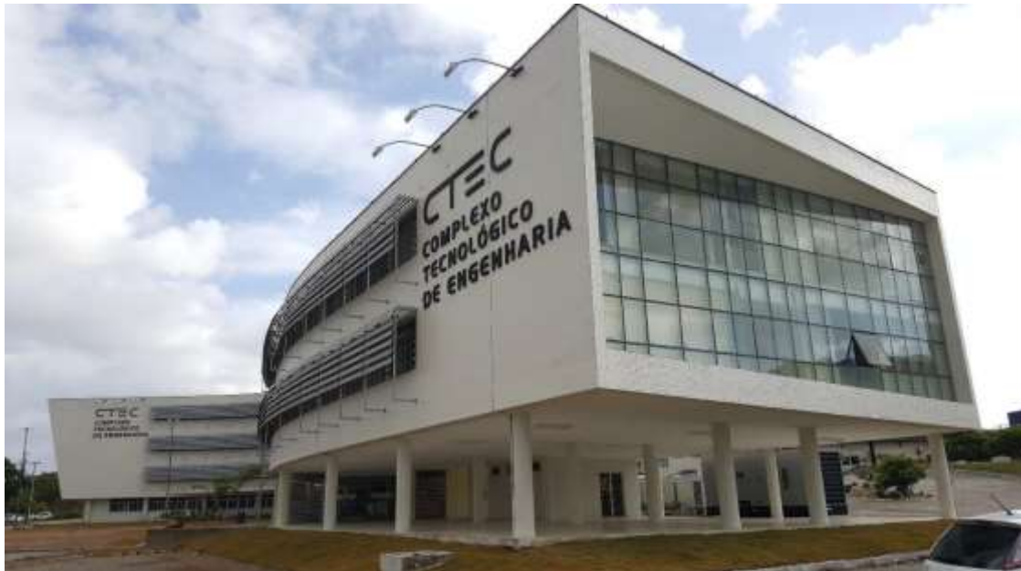
Figura 10 – Complexo Tecnológico de Engenharia – CTEC
