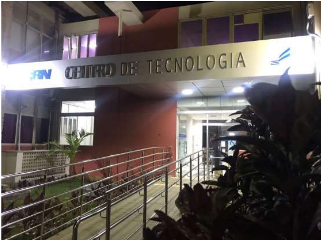
Figura 17 – Rampa de acesso ao Pavilhão Administrativo
