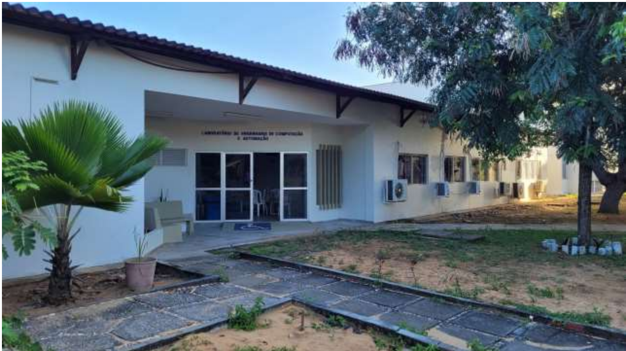
Figura 13 – Laboratório de Engenharia de Computação e Automação – LECA (exterior)
