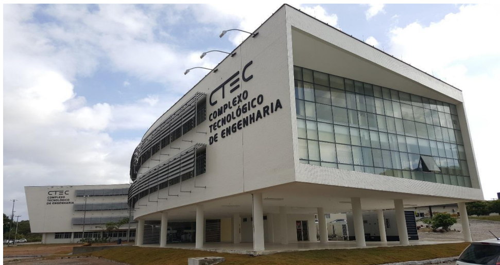
Figura 07 – Complexo Tecnológico de Engenharia – CTEC
