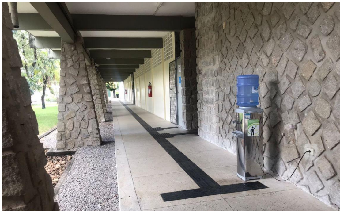
Figura 13 – Piso Tátil Direcional no Setor IV
