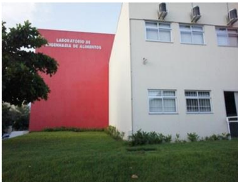
Figura 06 – Prédio dos Laboratórios de Engenharia de Alimentos – LEA
