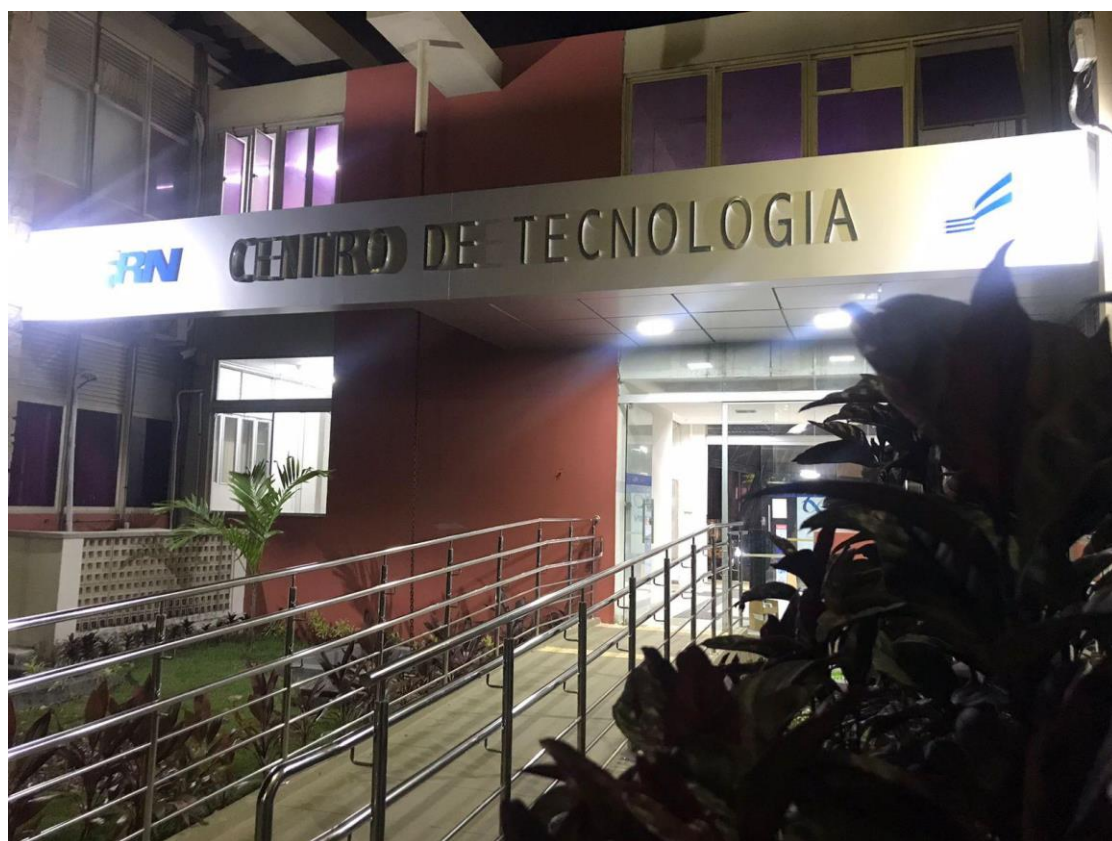
Figura 14 – Rampa de acesso ao Pavilhão Administrativo
